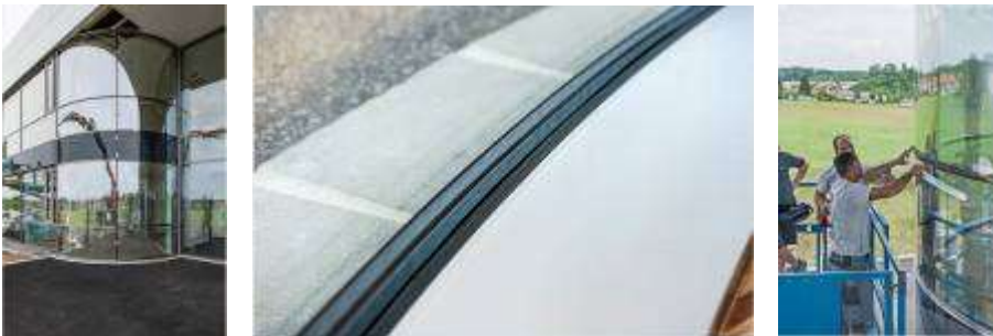
Photos 11, 12 et 13 : les éléments en vitrage isolant ajustés avec précision sont ensuite solidement fixés à la sous-construction portante avec des bandeaux en aluminium.
