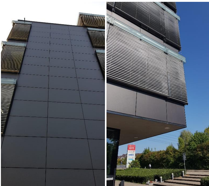
Abb. 2 und 3: Die ehemalige Schiefer-Fassade und -Brüstung wurde durch Dekton® Sirius von Cosentino ersetzt. Quelle: Cosentino
