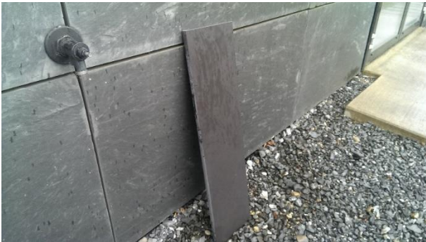
Abb. 5: Optisch ist Dekton® Sirius kaum von der Schieferplatte zu unterscheiden. Doch die ultrakompakte Oberfläche ist nur halb so stark und mehr als 50 Prozent leichter.
