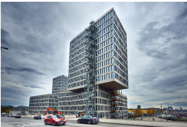
Abb. 1: Das KAP WEST in München (hier noch mit einer Behelfs-Außentreppe aus Brandschutzgründen am Südturm) ist seit Mitte 2020 komplett bezogen. Dekton® im Farbton »Keon« bekleidet die Fassade des urbanen Bürogebäudes.
