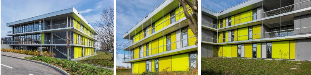
Abb. 1-3: Der Neubau der Theodor-Heuglin-Schule in Ditzingen: Die Fassade ist als Pfosten-Riegel-Konstruktion mit raumhohen Verglasungen und umlaufenden Fluchtbalkonen ausgeführt. Damit der Baukörper bei heruntergefahrenem Sonnenschutz nicht zu massiv wirkt, wählte man textile ZIP-Screens, die farblich mit der Umgebung harmonisieren.
