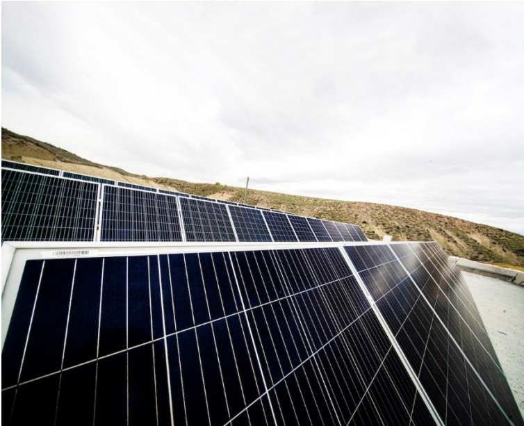
Abb. 3: 37.000 Photovoltaik-Module werden am Hauptsitz von Cosentino errichtet.
