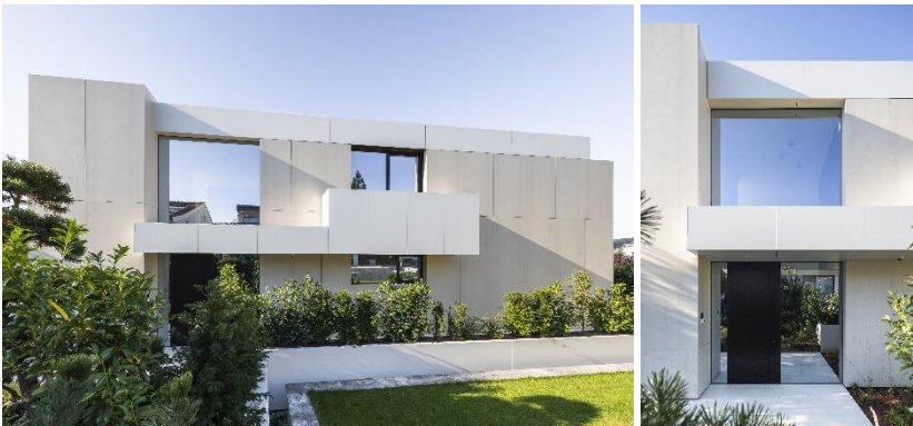
Abb. 2 und 3: Die vorgehängte hinterlüftete Fassade besteht aus 1,2 cm starkem Dekton by Cosentino in den Farbtönen Danae in der Vertikalen und Zenith auf horizontalen Elementen.
