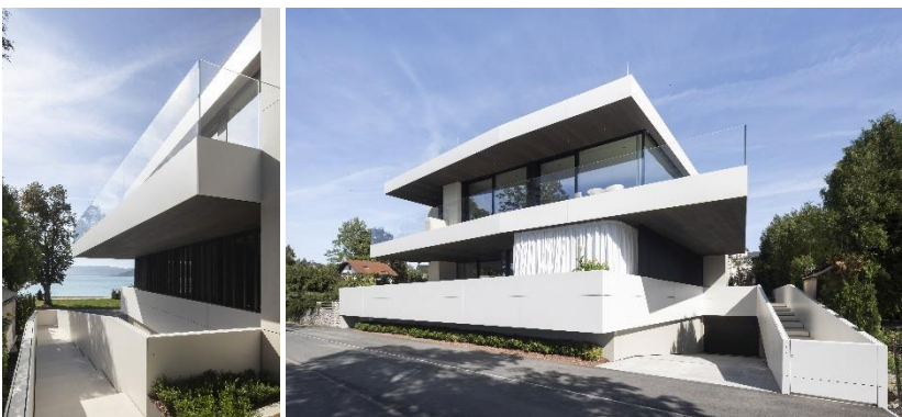
Abb. 4 und 5: Auch die Brüstungen wurden mit Dekton Zenith in 1,2 cm Stärke ausgeführt. Schönes Detail: Auf Blechverkleidungen an den Attiken konnte verzichtet werden.
