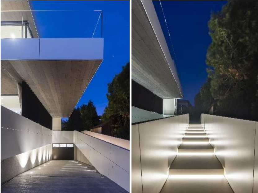
Abb. 26 und 27: Willkommen: Abfahrt in die Tiefgarage und Rampenstiege zum Haupteingang.
