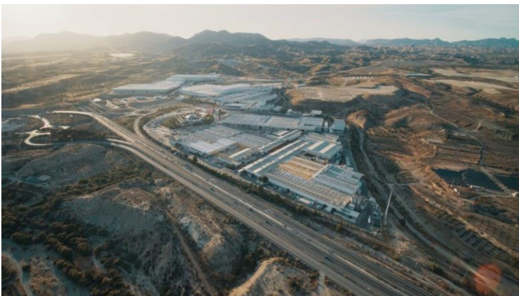
Fig. 4 : Cosentino investit dans la durabilité : en 2022, l'une des plus grandes installations photovoltaïques d'Europe (37.000 modules photovoltaïques d'une puissance de crête de 540 watts chacun) sera mise en service au siège de l'entreprise à Cantoria, dans le sud de
