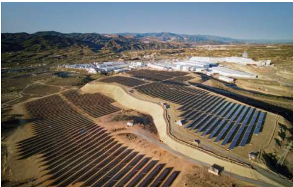
Abb. 2: Auf Cosentinos Firmengelände in der Sierra Südspaniens entsteht die größte selbstgenutzte Photovoltaikanlage des Landes. Die 37.000 Solarmodule haben eine Energieerzeugungskapazität von etwa 34 GWH/Jahr. Foto: Cosentino
