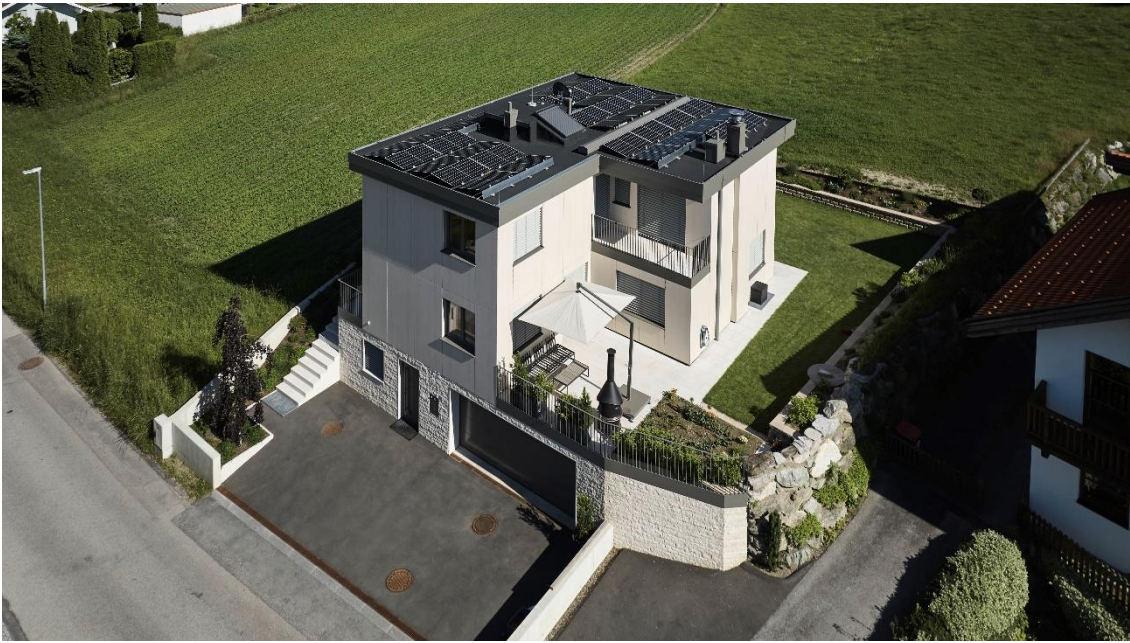
Abb. 2: Die sandfarbene Fassade aus Dekton® Danae gleicht dem Gestein der umgebenden Berge sowie dem Naturstein am Gebäudesockel.
