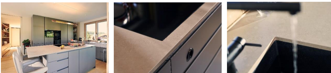
Abb. 12, 13, 14: Die Küche ist mit einer 2 cm starken Arbeitsplatte aus Silestone® Coral Clay von Cosentino mit matter Suede-Textur ausgestattet. Die Kanten sind leicht angefasst. Kochfeld und Spülbecken wurden flächenbündig eingesetzt.
