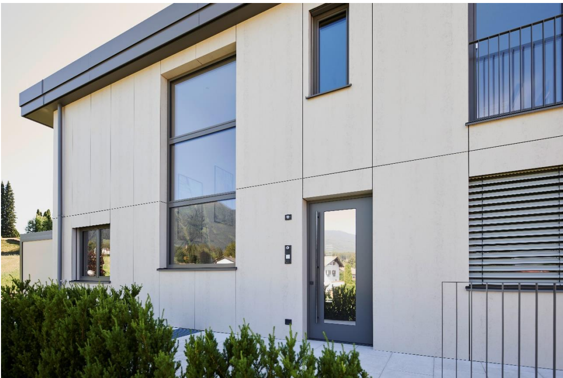
Abb. 3: Geschosshohe Fassadenelemente ermöglichen die Gestaltung einer nahezu monolithischen Gebäudehülle mit perfekt abgestimmtem Fugenbild.
