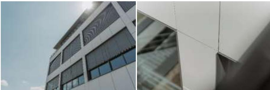
Abb. 5: Die energetisch hocheffiziente Vorhangfassade ist mit Dekton Zenith von Cosentino verkleidet. Dekton besteht aus natürlichen und recycelten Mineralpartikeln, die in einem CO<sub>2</sub>-neutralen Prozess ultraverdichtet und gesintert werden. Abb. 6: Die Dekton-Platten wurden mit höchster Präzision zugeschnitten und von außen unsichtbar mit Hinterschnittankern von Keil an der Unterkonstruktion befestigt.
