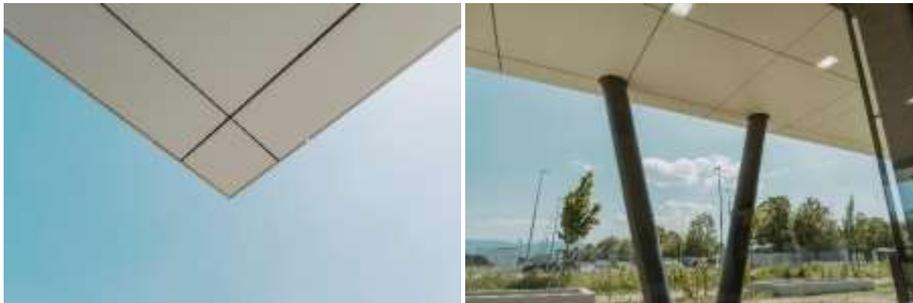
Abb. 11: Die von außen unsichtbare Befestigung der Dekton-Platten mit Hinterschnittankern bewährt sich auch an der Untersicht im Erdgeschoss. Abb. 12: Für die V-förmigen Säulen wurden ellipsenförmige Ausschnitte mit dem Wasserstrahlschneider angefertigt.
