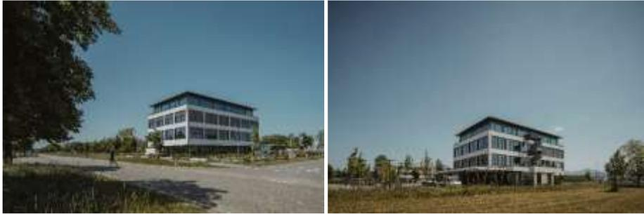
Abb. 1 und 2: Das Wertehaus der Volksbank Breisgau-Markgräflerland eG in Eschbach. V-förmige Stützen tragen die Ausleger der Geschosse. Auf der Rückseite des Gebäudes befindet sich die Außen-Feuertreppe.
