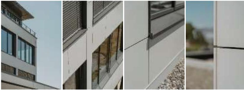
Abb. 7, 8, 9, 10: Dekton-Platten ermöglichen eine fugenarme Fassadengestaltung. Die präzise Linienführung schließt bis an die Fensteröffnungen und die Kanten des Gebäudes an.
