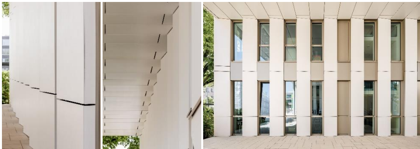
Abb. 7 und 8: Schräggestellte Dekton-Elemente geben der Fassade einen dynamischen Look mit einem sehr präzisen Fugenbild. Abb. 9: Das homogene und porenfreie Material ist UV-, farb- und fleckenfest. Selbst Graffiti lässt sich einfach entfernen.
