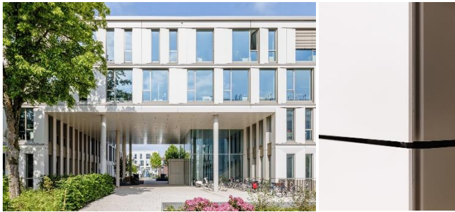
Abb. 5: Auch die Untersicht im offenen Durchgang ist mit Dekton im hellen Farbton Aeris verkleidet. Abb. 6: Die Dekton-Platten in 1,2 cm Stärke sind mit Hinterschnittankern von außen unsichtbar an der Unterkonstruktion befestigt.
