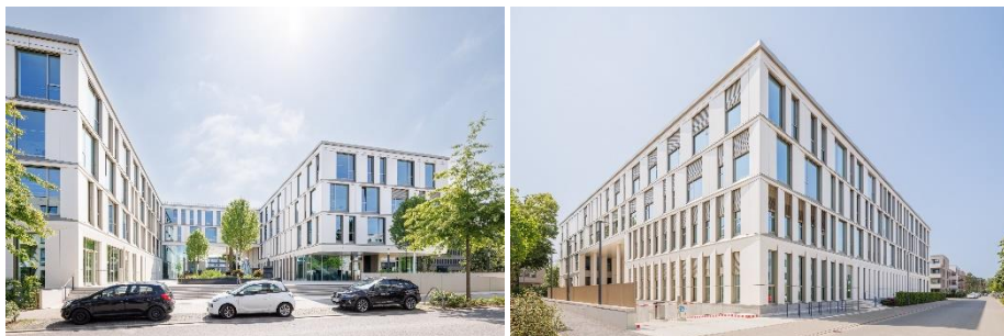
Abb. 1: Das U-förmige Gebäude öffnet sich zur Straße hin mit seinem attraktiven Innenhof. Abb. 2: Die vorgehängte hinterlüftete Fassade ist mit Dekton Aeris und Kreta (im Sockelgeschoss) von Cosentino verkleidet.
