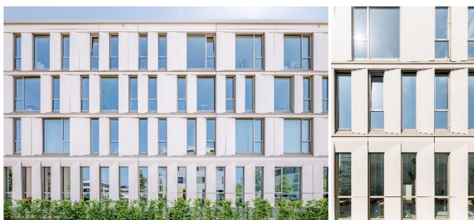
Abb. 3: Die Fassade besteht aus transparenten und opaken Elementen in nur zwei Breiten, die unterschiedlich angeordnet wurden. Abb. 4: An die zurückgesetzten Fenster schließen die Dekton-Platten in einem flachen Winkel an. Im Freiraum dahinter verlaufen die Regenfallrohre.
