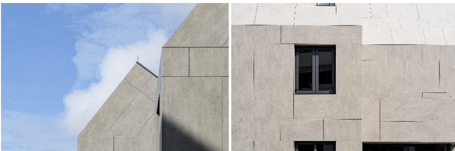
Abb. 7 und 8: Die geringe thermische Ausdehnung von Dekton ermöglicht enge Fugen.
