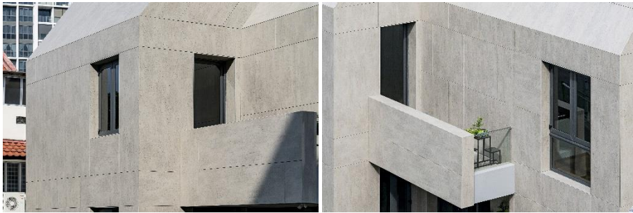
Abb. 9 und 10: Die homogene Farbgebung ermöglicht die Gestaltung einer monolithischen, modernen Gebäudehülle.
