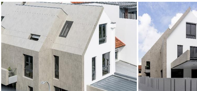
Abb. 13 und 14: Dekton Keon schützt das Gebäude wie eine Muschelschale vor starker Sonneneinstrahlung und sorgt so für angenehme Temperaturen im Inneren.
