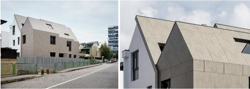
Abb. 1 und 2: Dekton Keon umschließt Fassade und Dach des "Shell House" in Singapur.
