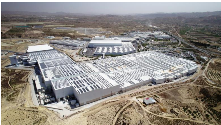
Abb. 1: Mit 28.000 neuen Photovoltaik-Paneelel ausgestattet: Cosentinos Hauptsitz und Industriepark in Cantoria, Almería, Südspanien.
