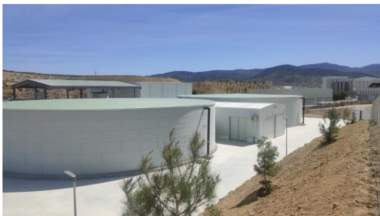
Abb. 2: Das neu errichtete Klärwerk von Cosentino reinigt auch die Abwässer aus den umliegenden Gemeinden.
